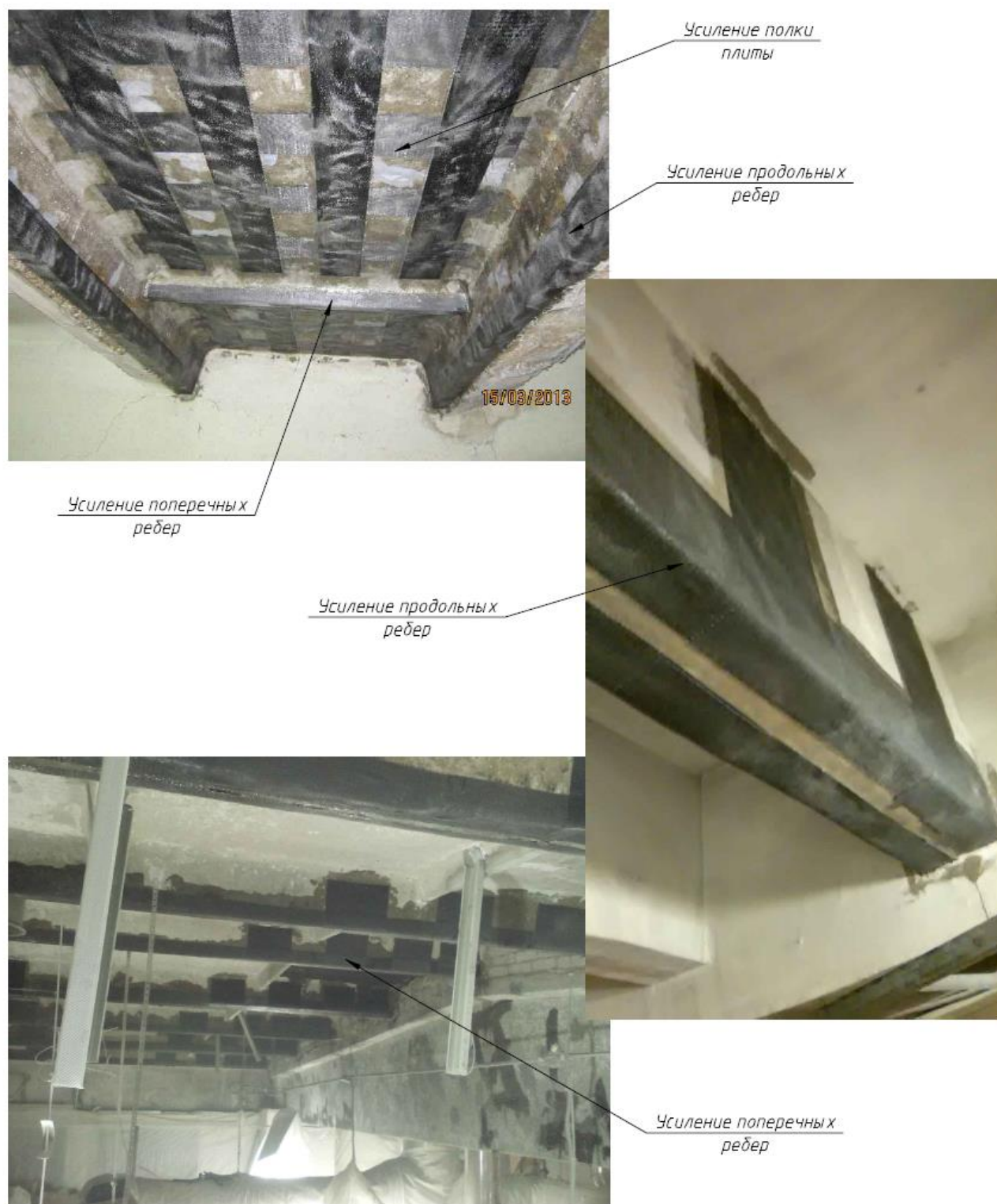
Рисунок 5.78 Пример выполнения усиления углеродными лентами железобетонных сборных плит
