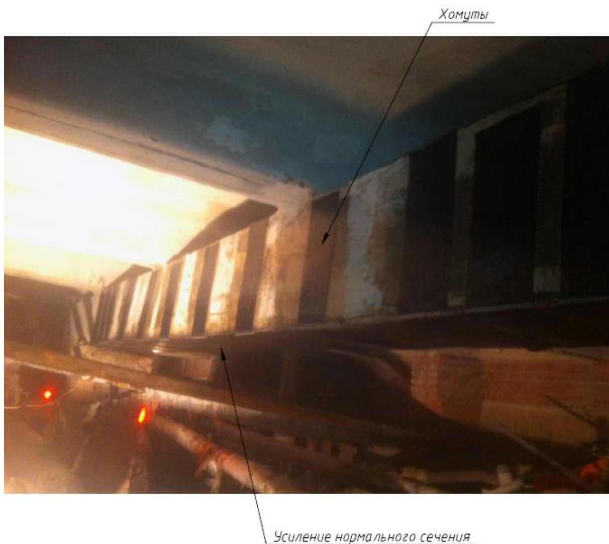
Рисунок 5.52 Пример усиления ригеля углеродными лентами
