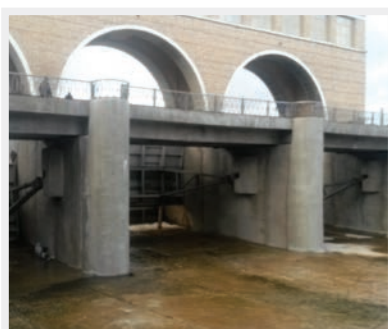
Окончательный вид сооружения после ремонта
