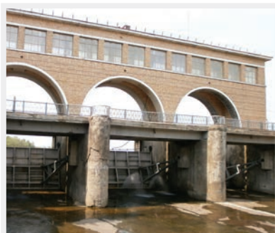
Общий вид сооружения до начала работ
